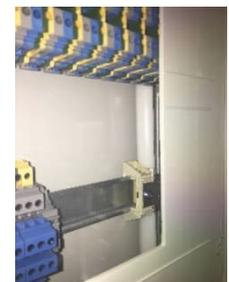
Bild „Beispiel schutzisoliert aufgebaute Hutprofilschiene“
