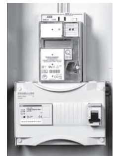
Bild 7: Zählerfeld mit BKE-MARS ZE530 (Nachrüstung)
