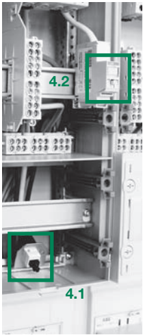
Bild 4: Zählerplatz mit BKE-I
