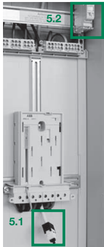
Bild 5: Zählerplatz mit Dreipunkt-Befestigung
